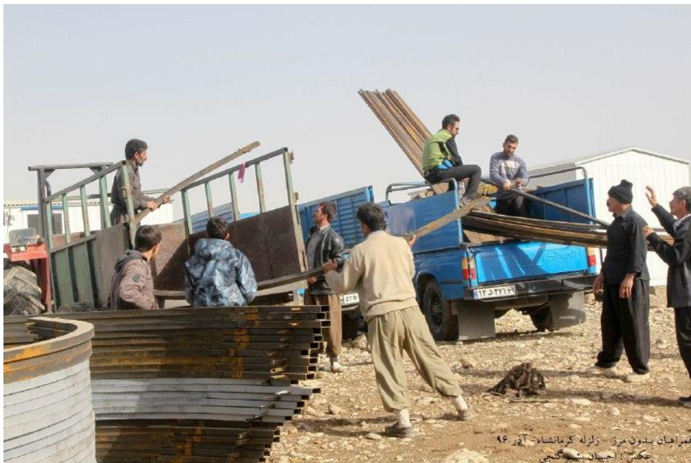
تصویر شماره ی 6: چارچوب های آهنی برای ساخت آغل
