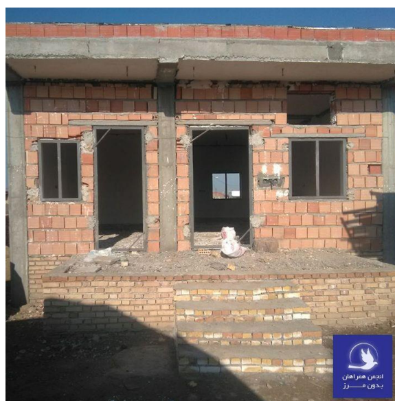
تصویر شماره ی ۳: گچ کاری واحد مسکونی در دی ماه ۹۸
